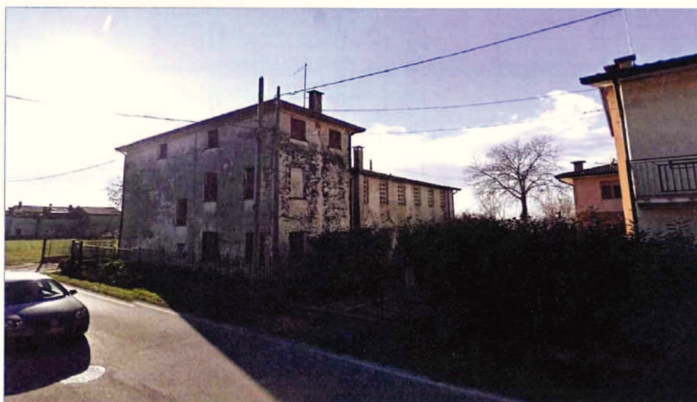
Fabbricato visto da NORD
