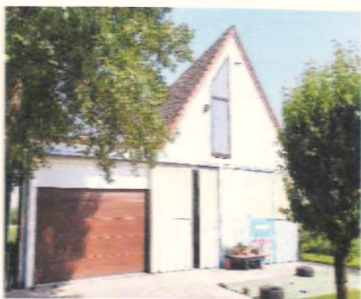
Vista da Ovest
